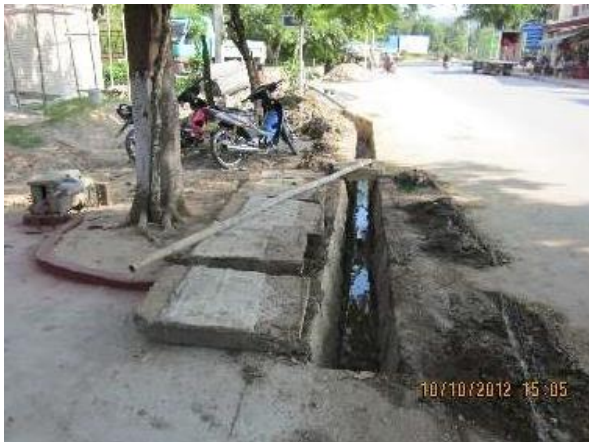
ຮູບທີ 20. ຊ້າຍ: ກິດຈະກຳອະນາໄມຮ່ອງລະບາຍນໍ້າ ຂອງແຂວງຫຼວງພະບາງ ໂດຍອົງການພັດທະນາ ແລະ ບໍລິຫານຕົວເມືອງ (UDAA), ຂວາ: ການສ້ອມແປງຮ່ອງລະບາຍນໍ້າ ໂດຍອົງການ UDAA (UDAA, 2013)
