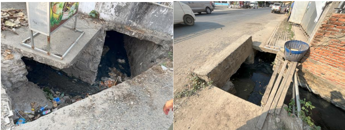
ຮູບທີ 24. ຕົວຢ່າງຂອງຮ່ອງລະບາຍນ້ຳແບບປົກປິດທີ່ເປັນມຸມສາກ
