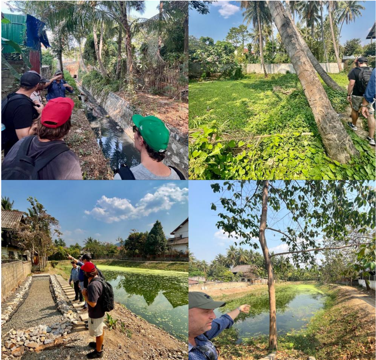
ຮູບທີ 34. ຕົວຢ່າງລະບົບຕ່ອງໂສ້ຂອງລະບົບໜອງ/ດິນທາມມໍລະດົກຂອງອົງການ UNESCO ທີ່ຕັ້ງຢູ່ໃນພື້ນທີ່ທີ່ GRET ສະໜັບສະໜູນ ແນວທາງການຄຸ້ມຄອງໂດຍຊຸມຊົນ, ລວມທັງການສະໜັບສະໜູນການບໍາບັດນໍ້າເບື້ອນຜ່ານພື້ນທີ່ດິນບໍລິເວນນໍ້າຍ່ອຍ (ເບື້ອງຊ້າຍລຸ່ມ) ແລະ ໜອງນໍ້າທີ່ບໍາບັດດ້ວຍພືດ (ລຸ່ມເບື້ອງຂວາ).
